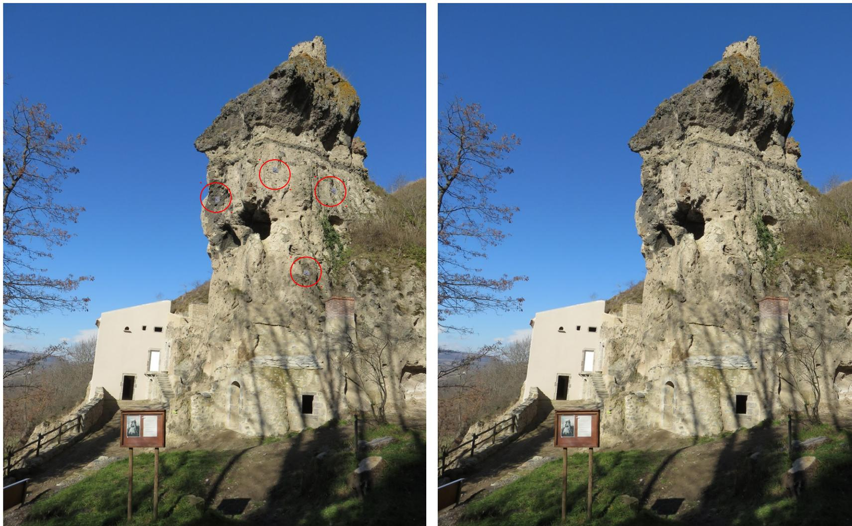
Figure 5 : Simulation des ancrages sans et avec peinture suivant RAL proposés (© A3-Paysage)
