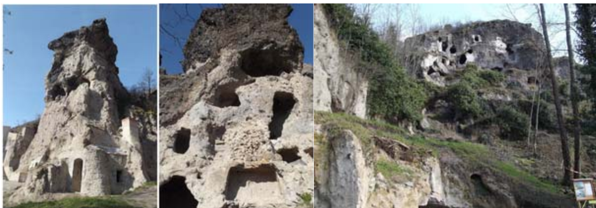
Figure 8 : À gauche : Tour Maurifolet ; au milieu : éperon de la Grelette ; à droite : grottes troglodytes ouest (source dossier)
