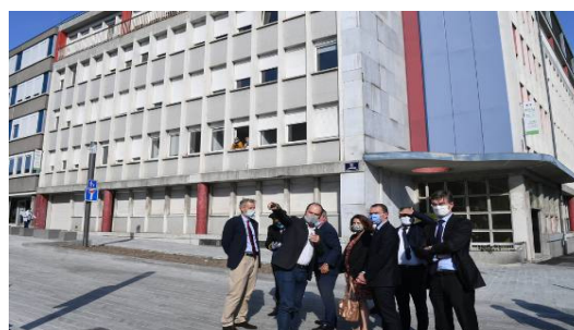
Site Léo Lagrange de la Direction Départementale des Territoires, durant la visite du ministre Olivier Dussopt
