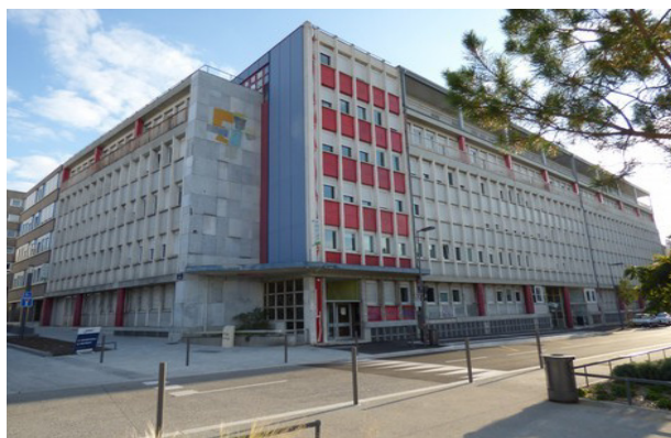
Site Léo Lagrange de la Direction Départementale des Territoires
