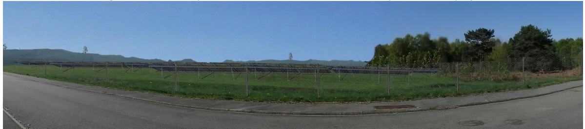
Figure 86 : Vue 2, depuis la route d'accès à l'Ouest après l'implantation du projet
