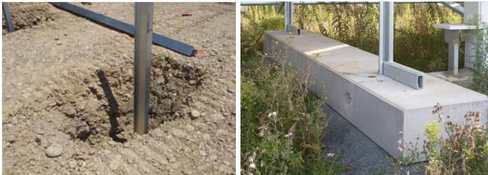
Figure 15 et 16 : Types de fondation - pieux battus (gauche) et semelle béton (droite)
