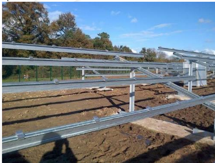
Figure 12 : Exemple de chantier de construction – pose de structures (Crédit photo : SERGIES, 2015)
