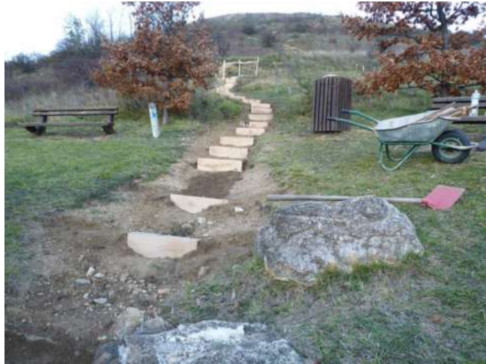
Réparation accès Puy d'Anzelles (pour partie)
