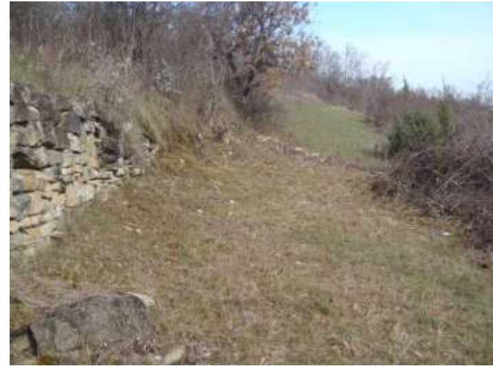
Passage pour la future clôture du parc 4
