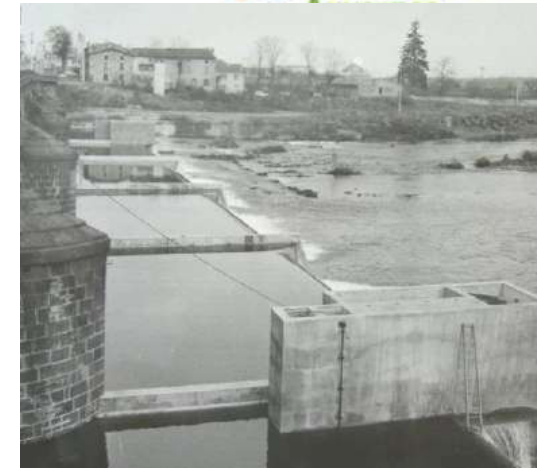
Le seuil avec ses vannes en 1965 (source : archives départementales)
