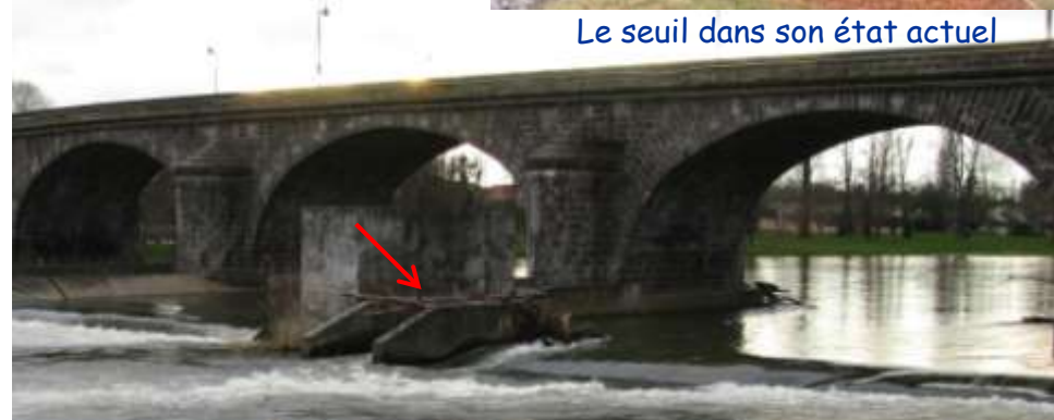
Le seuil avec sa passe à poisson encombrée et non fonctionnelle
