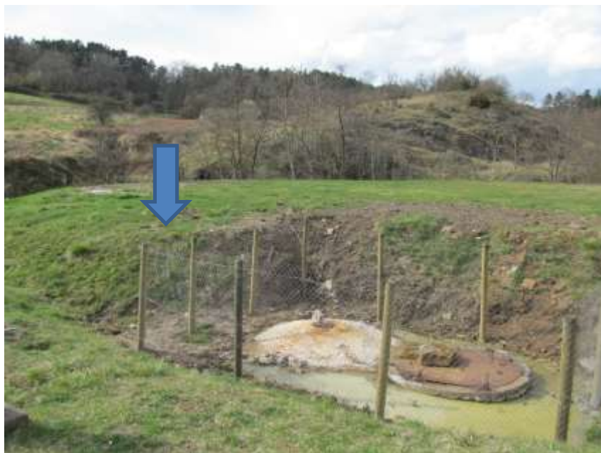
Projet d'enlèvement du remblai
