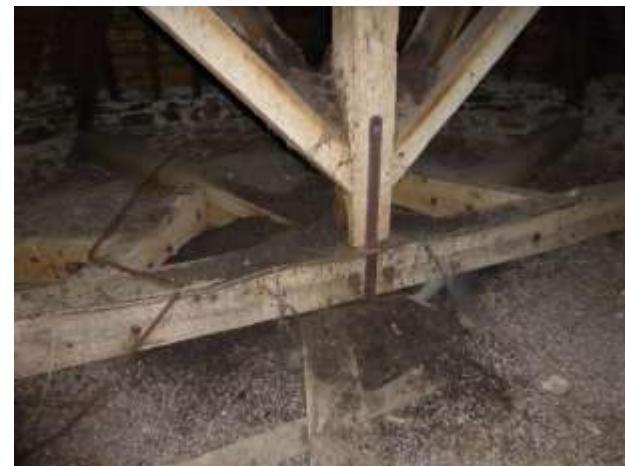
Nettoyage des combles
