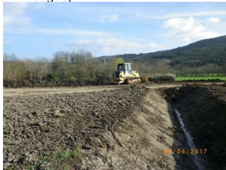
Travaux de remblaiement (photo DDT 63, 06/04/2017)
