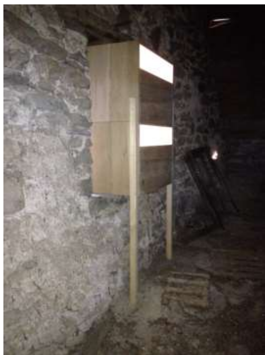
Pose de la chiroptière
