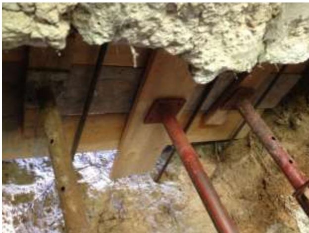
Renforcement de la voute avec du béton
