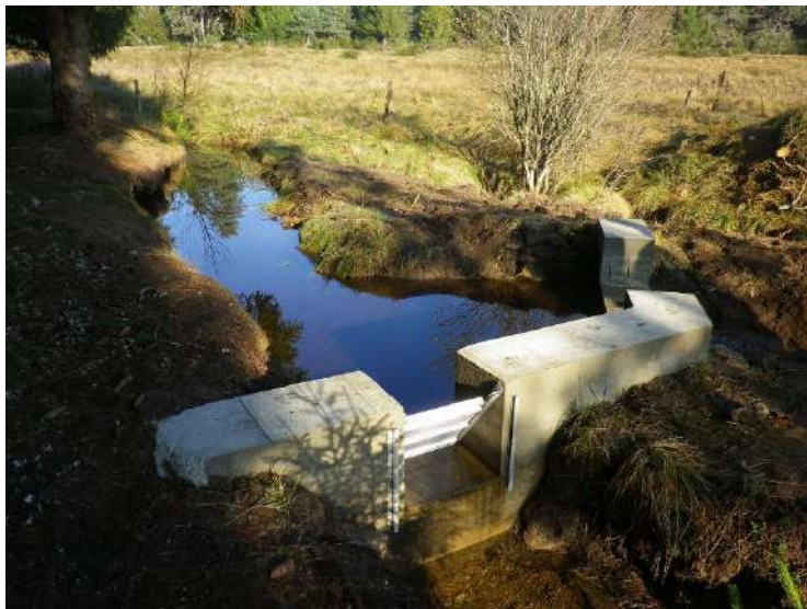
Prise d'eau des étangs après travaux
