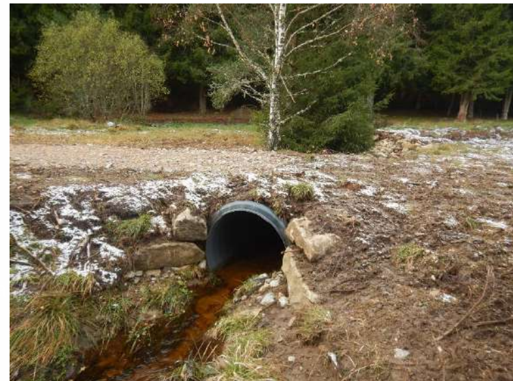
Franchissement du ruisseau après travaux
