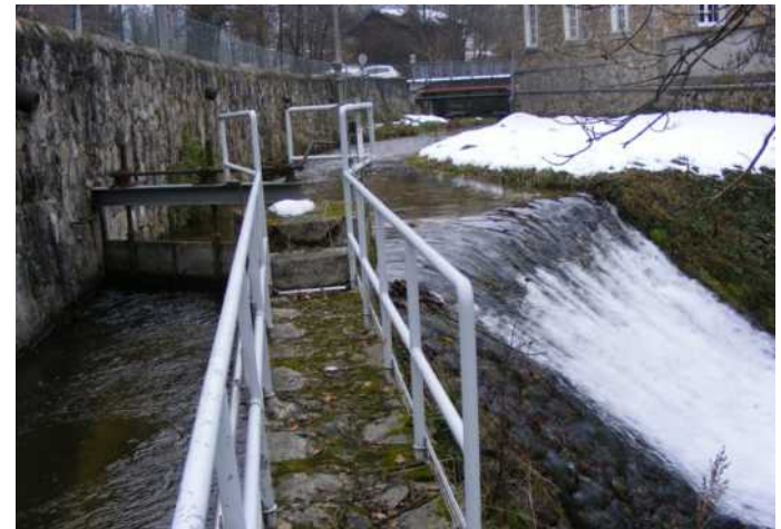
Prise d'eau sur le Vertolaye – obstacle à la continuité
