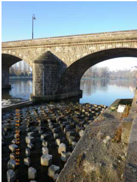
Seuil de Pont du Château Passe à macro-rugosité
