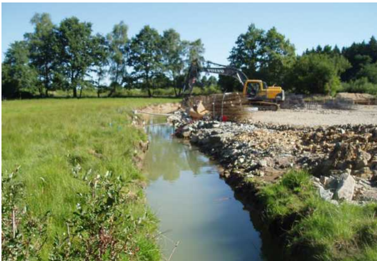
Plate-forme réalisée en zone humide à St-Ours les Roches
